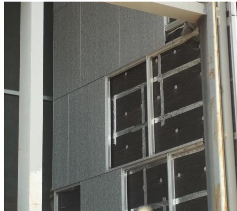
Pre-assemblaggio - facile installazione con viti <sup>1</sup>
